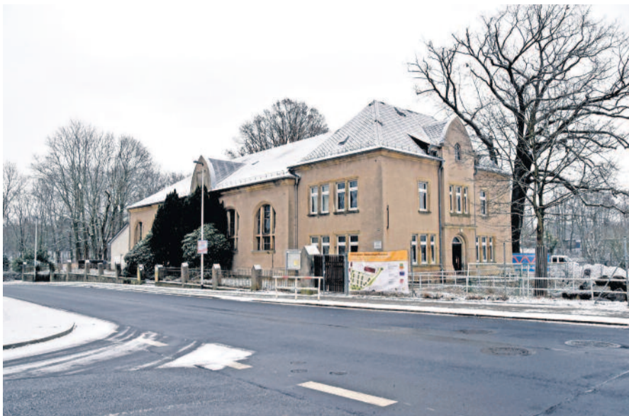
Im Januar 2024 waren die Bauarbeiten an der alten Turnhalle auf der Pulsnitzer Straße in vollem Gange. Verschiedene Faktoren verzögerten eine fristgerechte Fertigstellung. Nun muss die Stadt Radeberg Zinsen für die Nutzung der Fördergelder zahlen.
